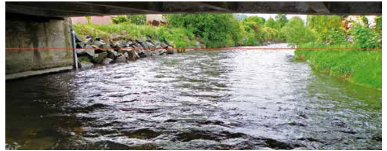
Obr. 8. Vodoměrná stanice Desná-Rapotín s vyznačením nejvyššího zaznamenaného vodního stavu (120,5 cm), pro který byl dopočten odpovídající průtok s využitím Chézyho rovnice
