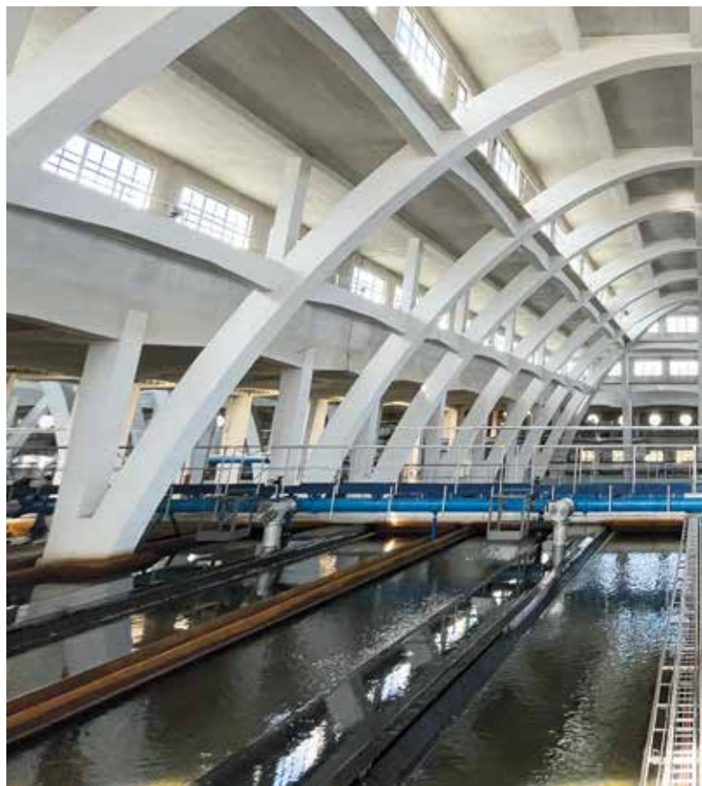
„Podolská katedrála“, tak se přezdívá hlavní filtrační hale ve vodárně. Foto: PVK
