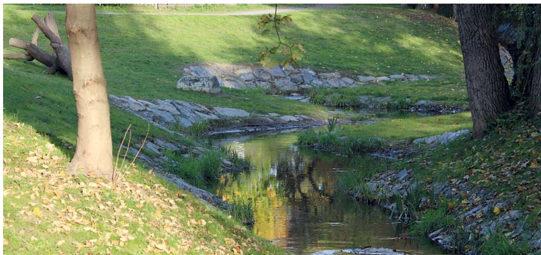
Proměna Kunratického potoka nad ulicí Vrbova se skutečně povedla.
