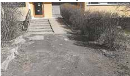
V ulici Bernolákova se bude opravovat přístupová cesta.
